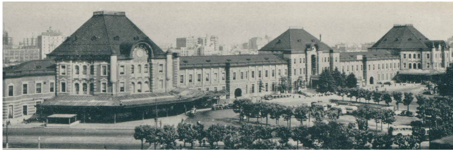
国鉄・東京駅(復旧)(東京都/昭和26年)
