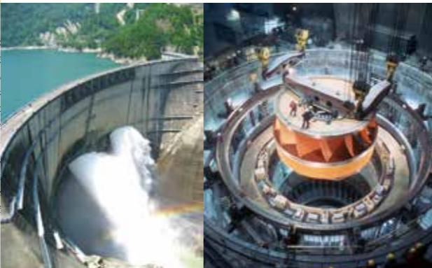
【図1】放水する黒部ダム(富山県)、黒部川第四発電所(富山県)の発電量は33.5万kWで国内第4位。【図2】北米最大のグランドクーリーダム発電所(ワシントン州)に設置されたフランス式水車。最大出力は75万kW。
