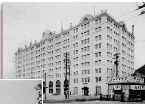
堂島ビルヂング(大阪市 大正12年)
